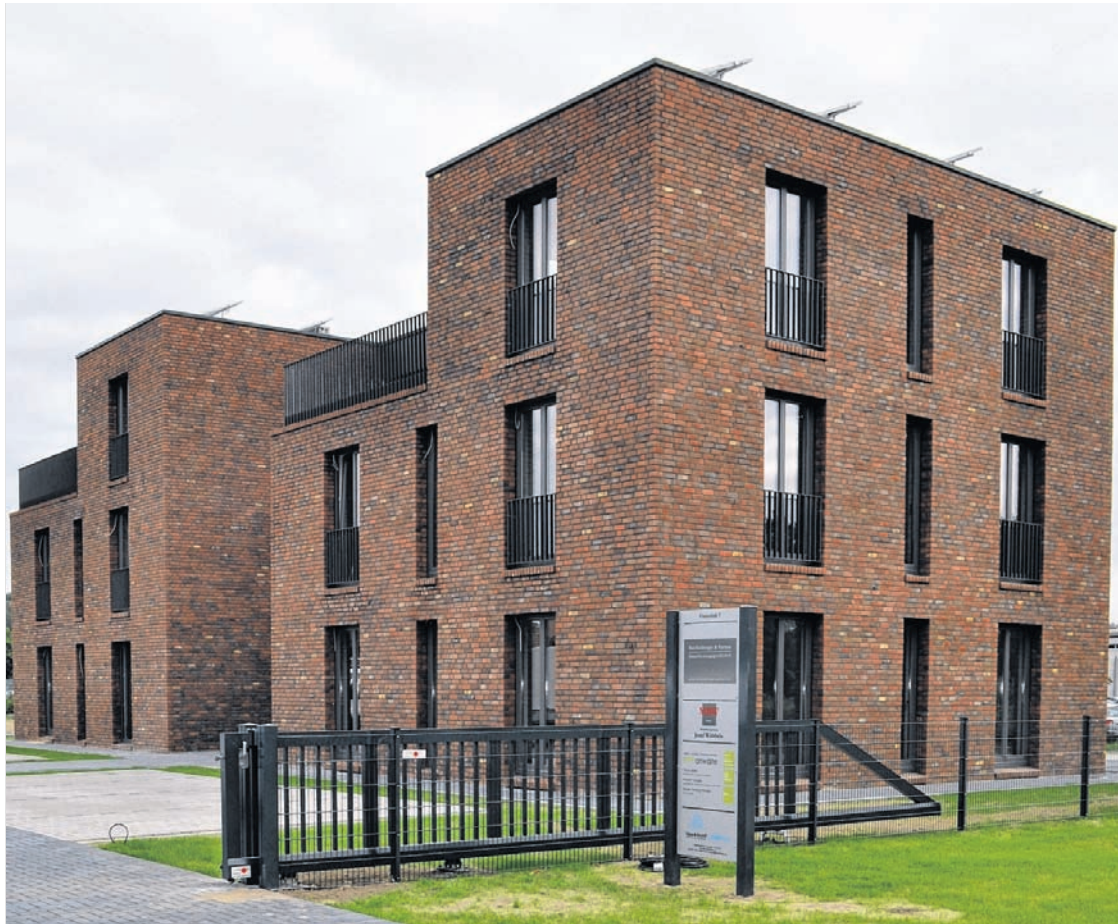
Der Eingangsbereich ist vom Fiskediek aus angelegt.
